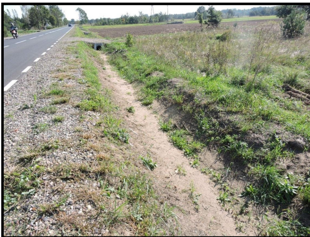
Fot. nr 2. Wyschnięty rów sąsiadujący z terenem inwestycyjnym.
