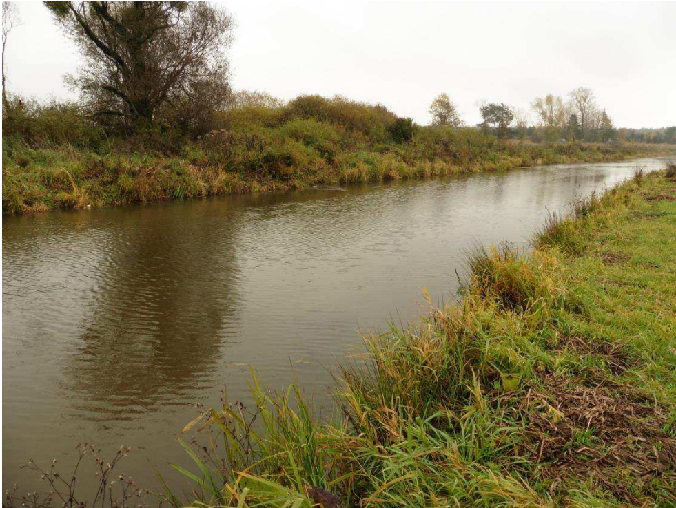
Fot. 1. Koryto Łasicy w miejscu istniejącego jazu i przepławki
