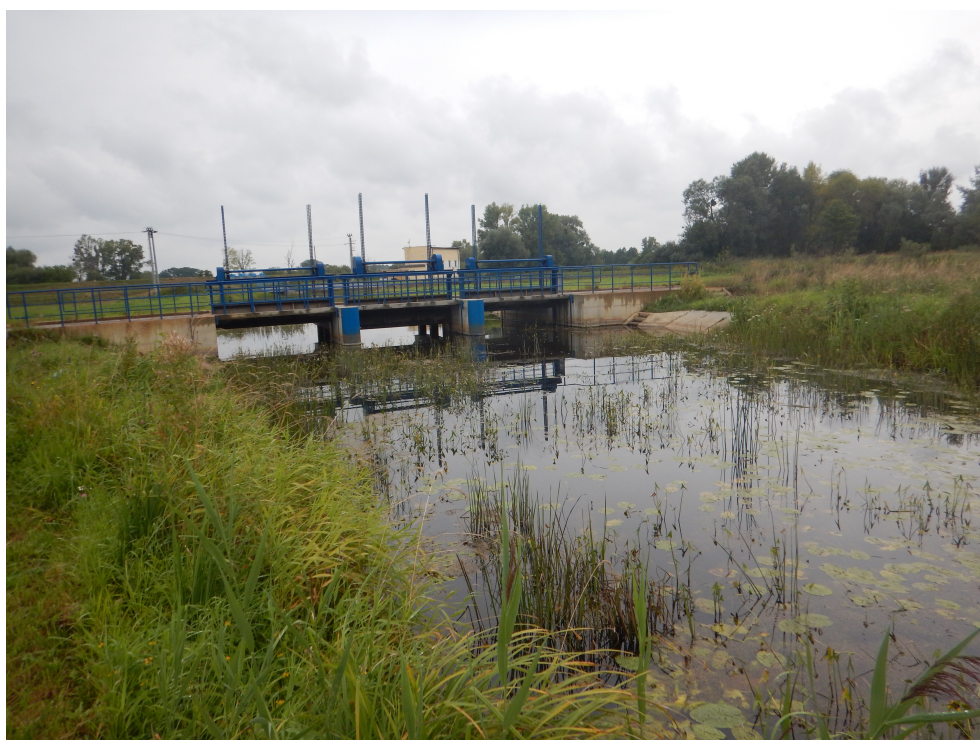
Fot. 6. Łasica – jaz poniżej stanowiska 2. W tle budynek pompowni Tułowice.
