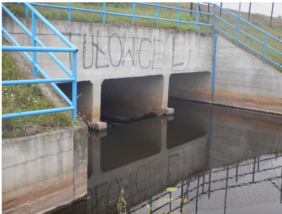
Fot. 7. Przepust pod wałem umożliwia migrację ryb z Bzury do Łasicy tylko przy wysokim poziomie wody.
